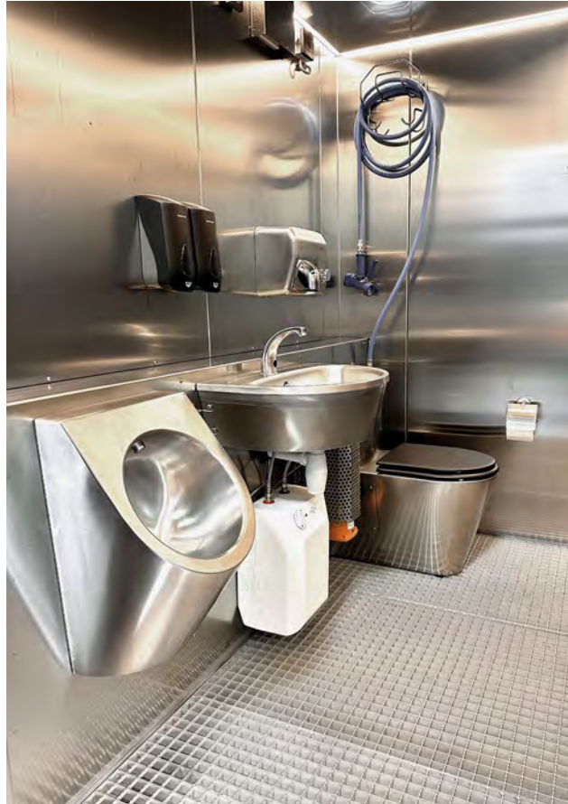
Die mobile Kabine bietet WC, Pissoir, Warmwasser-Waschbecken, Heizung und Entlüftung. Kontaktarme Bedienung und rostfreie Stahloberflächen erleichtern die Reinigung. Schmutzwasser wird über eine bodenintegrierte Wanne in die Kanalisation geleitet.
